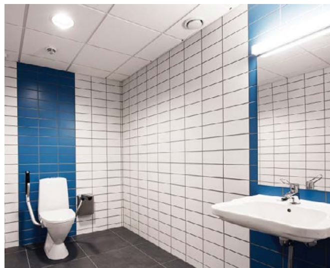
Golv og vegger skal ha synlig kontrast. Fastmontert utstyr f.eks. systernepanel skal ha synlig kontrast mot bakveggen.
