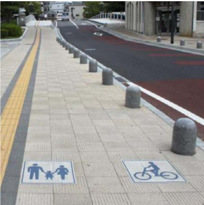
Figur 7 a og b: Kunnskapen rundt praktisk bruk av ledelinjer, med og uten taktil overflate må bedres. F.eks i Japan har de lange tradisjoner med ledelinjebruk (bilde til venstre). I Norge blir det nå arbeidet med å få gode regler både innendørs og i utearealer, hvor både farger og strukturer må gjennomtenkes. Bildet til høyre har god taktil overflate, men hva med kontrasten?
