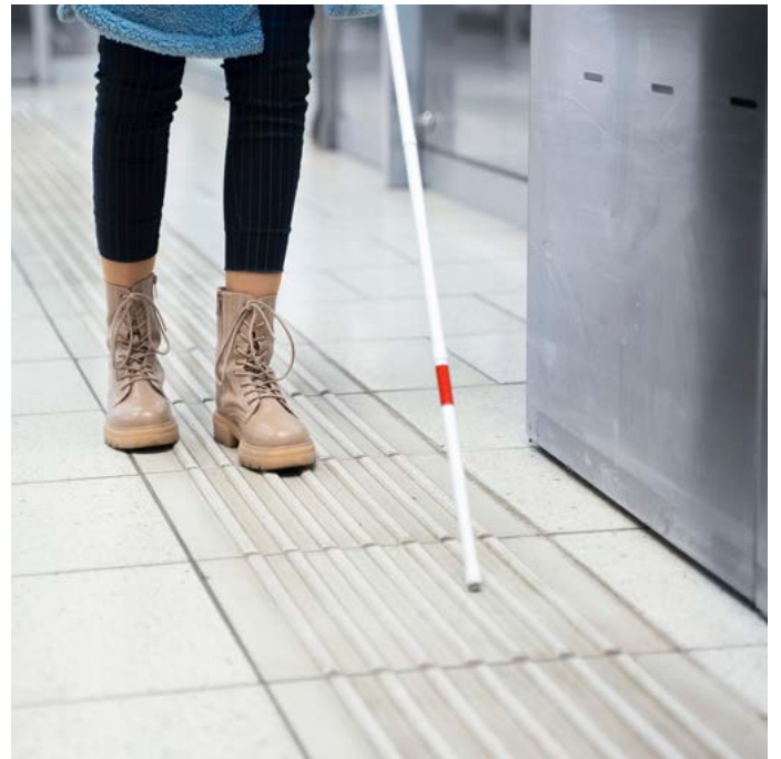
Figur 7 a og b: Kunnskapen rundt praktisk bruk av ledelinjer, med og uten taktil overflate må bedres. F.eks i Japan har de lange tradisjoner med ledelinjebruk (bilde til venstre). I Norge blir det nå arbeidet med å få gode regler både innendørs og i utearealer, hvor både farger og strukturer må gjennomtenkes. Bildet til høyre har god taktil overflate, men hva med kontrasten?
